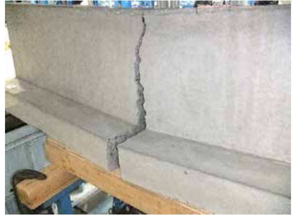
写真 20 破壊状況（裏側） 試験体記号：No.8 P_{max}=150 kN ・コンクリートの曲げ割れ
