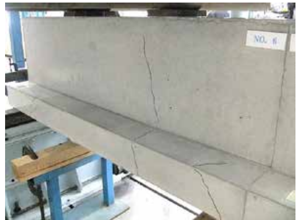
写真 16 破壊状況（裏側） 試験体記号：No.6 P_{max}=126 kN ・コンクリートの曲げ割れ
