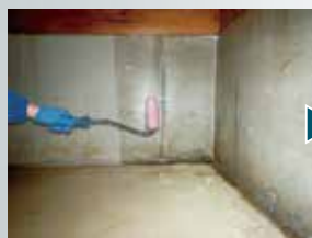
下塗り (プライマー)
