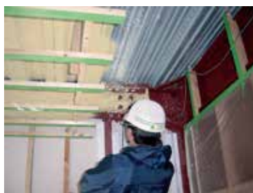
鉄骨梁への吹付(天井断熱)
