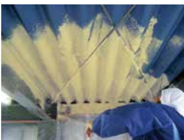
折板への吹付(天井断熱)
